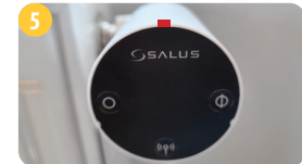
Stlačením ľubovoľného tlačidla spustíte proces adaptácie hlavice TRV s termostatickým ventilom. Proces trvá do 5 minút.
